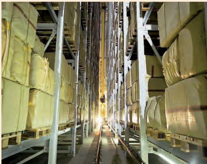
Das neue, hochmoderne Hochregallager für Hopfen in Mainburg The new ultramodern high-rack cold storage for hops in Mainburg
